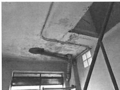
Dettaglio del soffitto nel piano seminterrato
